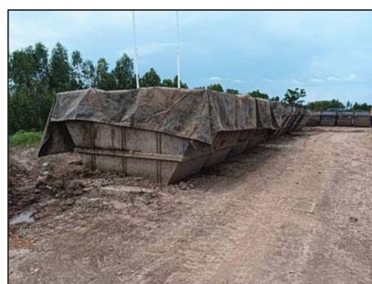
ภาพถ่ายที่ 2.2-16 ถังรวบรวมเศษหินจากหลุมเจาะ
