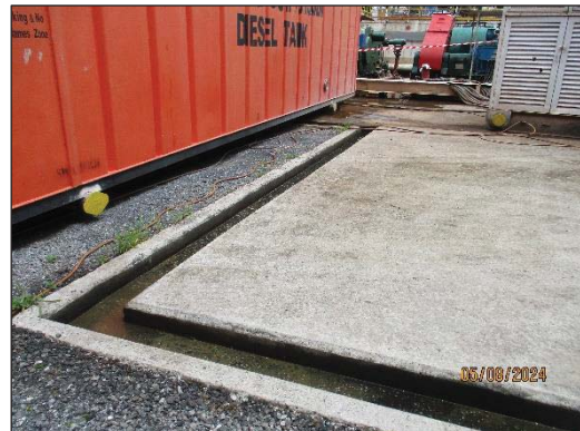
ภาพถ่ายที่ 2.2-9 ระบบระบายน้ำแบบแยกส่วน
